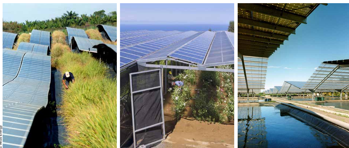
La première et la deuxième génération d'Agrinerergie, et des installations Aquanergie au-dessus de bassins d'élevage piscicole.
